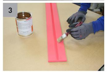
2) Spalmare in maniera uniforme, con l'ausilio di un pennello, il collante Piesse CP/700 sulla facciata interna della protezione in E.V.A. (anche nella fresatura) e sulla parete rispettando i segni a matita precedente mente realizzati (foto 3 e 4).Nota importante: il collante va steso su tutta la superficie di protezione e parete.
