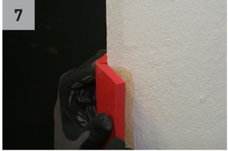
5) Piegare a 90° la protezione coprendo in tal modo completamente lo spigolo da proteggere. Comprimere con forza la protezione verso lo spigolo ed evitare di toccarla nelle prime 24 ore dall'incollaggio (foto 8).
