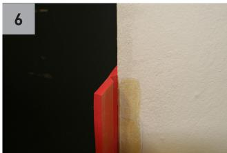
4) Posizionare la protezione facendo combaciare mezza facciata trattata con Piesse CP/700 (mantenuta aperta) con un lato dello spigolo da proteggere partendo dal basso verso l'alto per tutta la sua lunghezza (senza comprimere). Il bordo della fresatura riportata sulla protezione deve essere allineato con lo spigolo da proteggere (foto 6 e 7).
